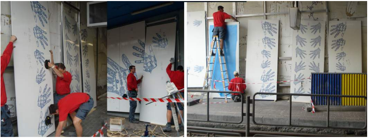
Installation des 213 modules illustrés sur l'ensemble de la station
